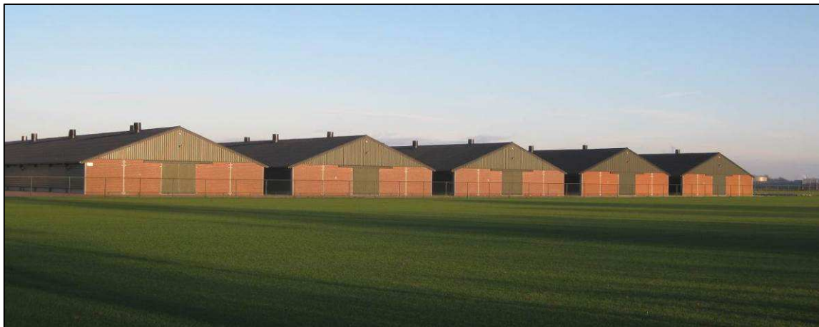
Figuur 12. Huidige situatie locatie Zandstraat 99.
