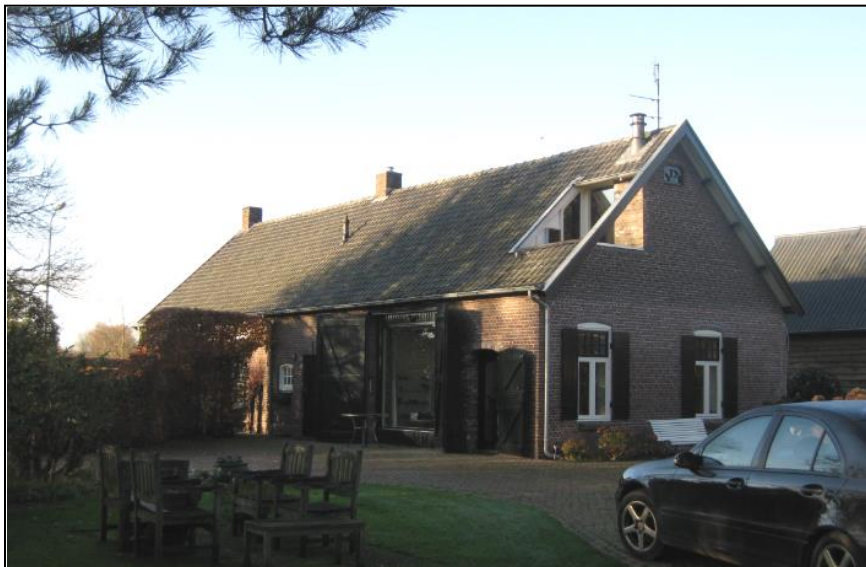
Figuur 11: Foto van de woning aan Sluisstraat 67
