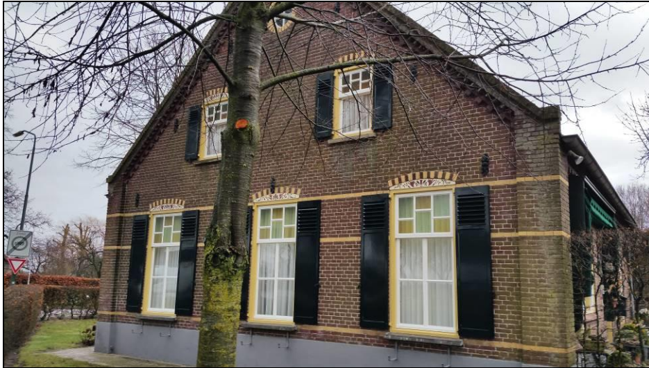
Figuur 4: Kopgevel woonboerderij Laan ten Boomen 30
