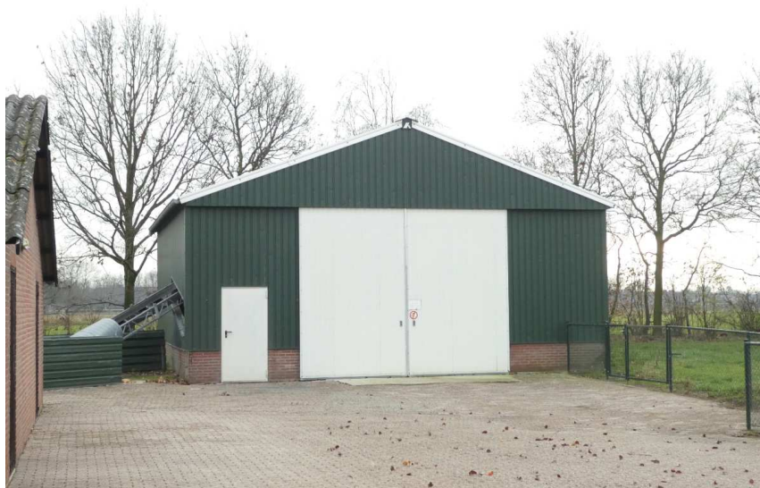
Figuur 10: Mestopslagloods binnen het plangebied
