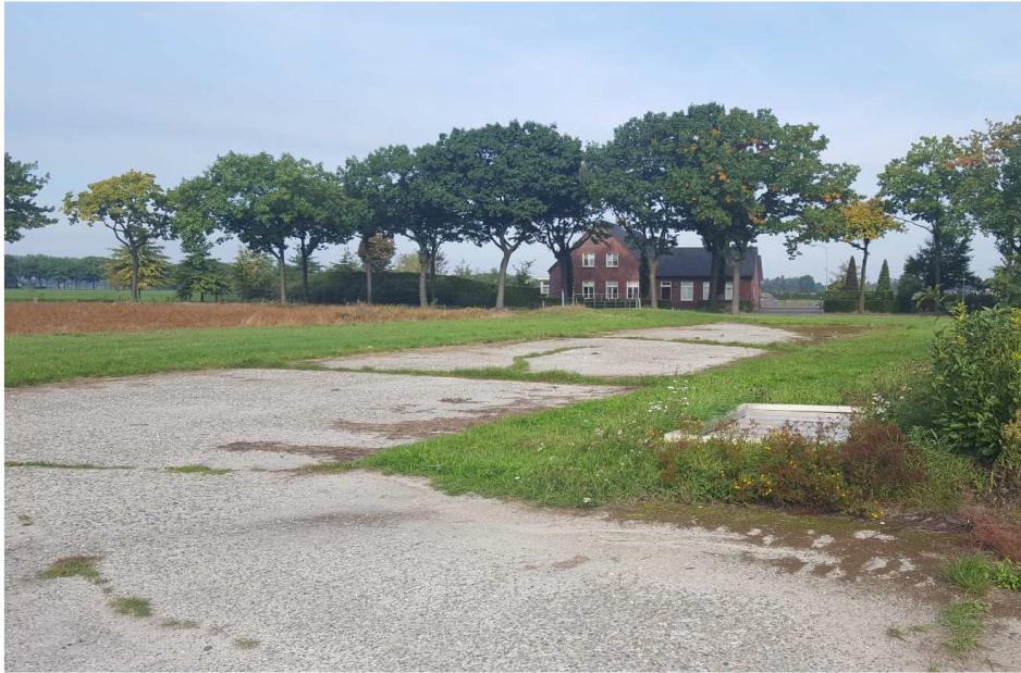
Figuur 10: Te saneren erfverharding en sleufsilo's binnen het plangebied
