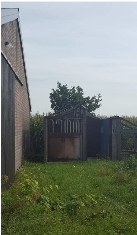
Figuur 8: Te slopen paardenstal binnen het plangebied
