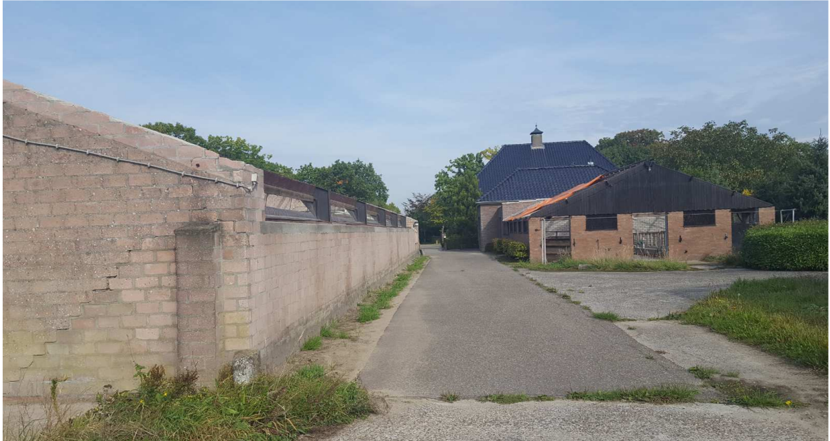
Figuur 7: Te slopen stallen binnen het plangebied, met de rundveestall aan de linkerzijde en de stal achter het woonhuis aan de rechter zijde van de foto
