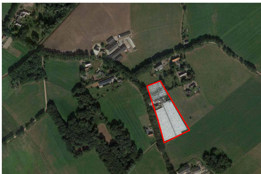
Planlocatie aan de Slievenstraat (luchtfoto Google Maps)
