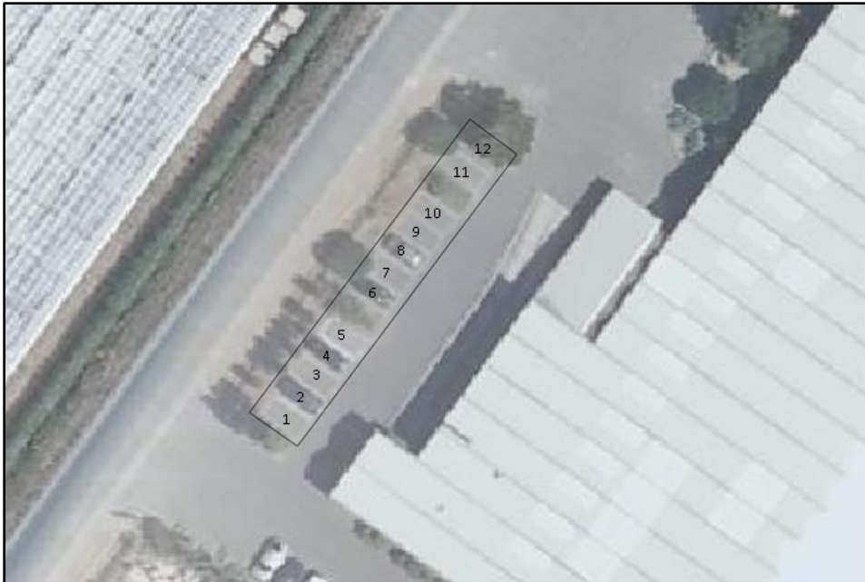
Afbeelding 20: Bestaande parkeervakken voor de bedrijfsloods van de boomkwekerij.
