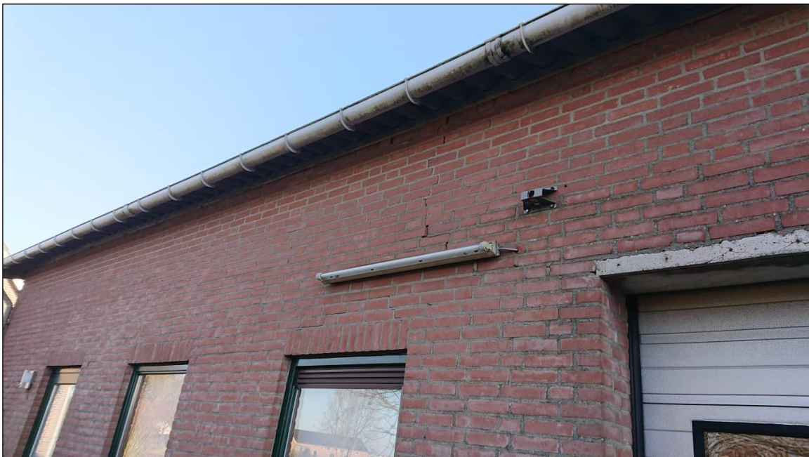
Figuur 30: Afwerking dak loods
