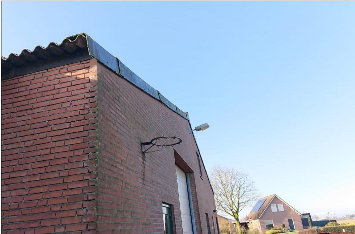
Figuur 31: Afwerking buitenkant loods
