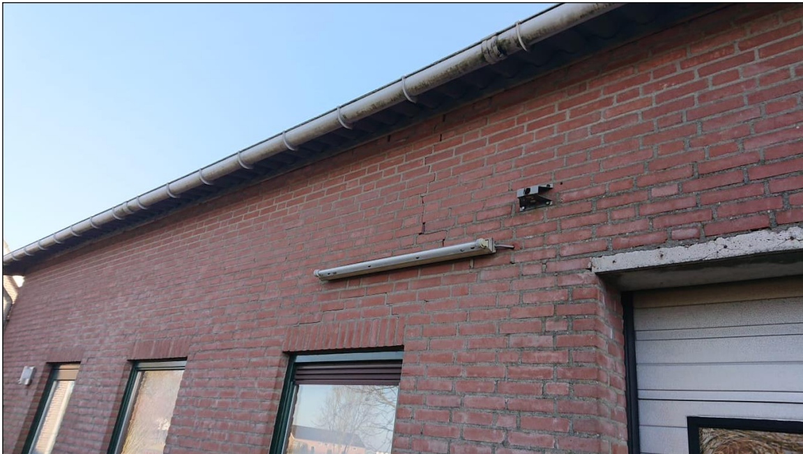
Figuur 30: Afwerking dak loods
