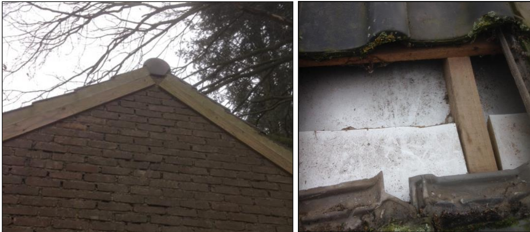
Figuur 24: Dakbeschot tweede woning
