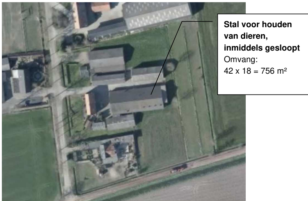
Figuur 6: Luchtfoto van het plangebied voor sloop van de dierenverblijven in 2014
