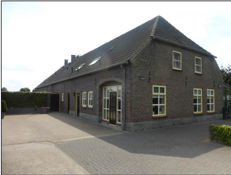
Figuur 5: Zuidelijk deel cultuurhistorisch waardevolle woonboerderij aan Verhagenstraat 13
