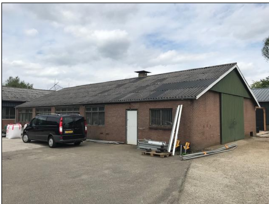
Figuur 8: Te slopen bedrijfshal
