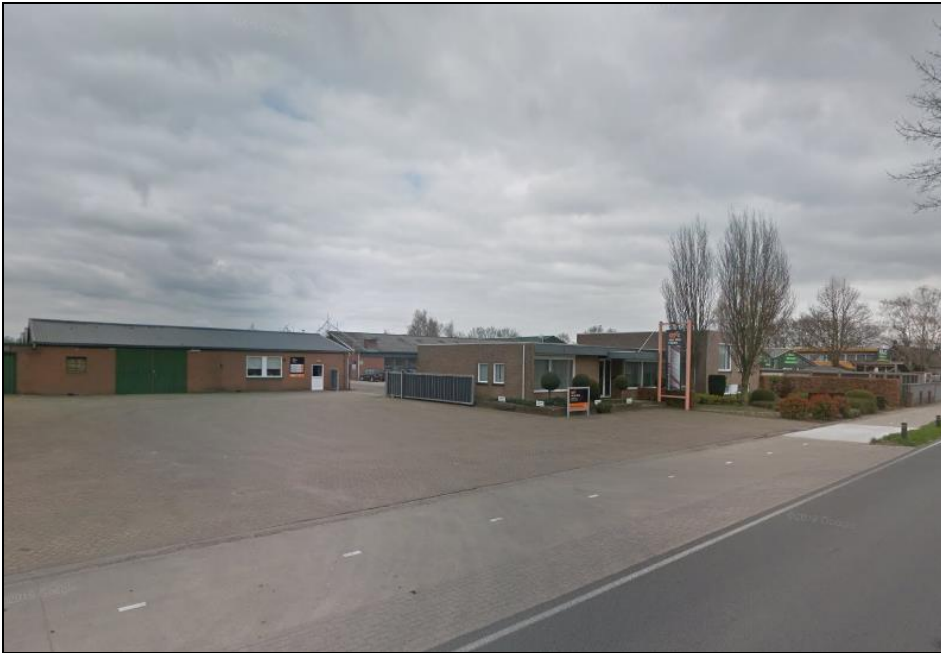
Figuur 6: Nieuwendijk 90, zicht op het kantoor en de bedrijfshallen
