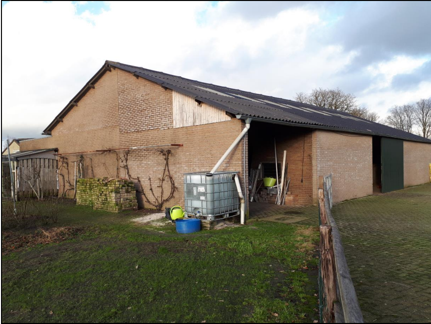
Figuur 8: Achterzijde loods
