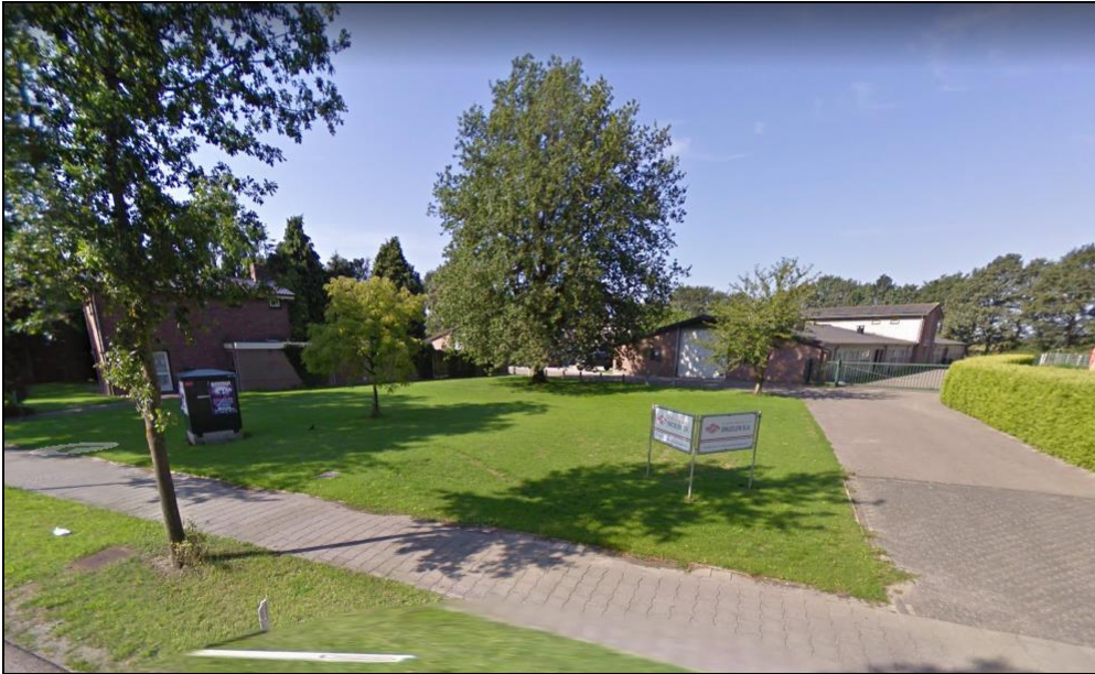
Figuur 7: Bedrijfsgebouwen in een tweede lijn, links het woonhuis Lieropsedijk 27
