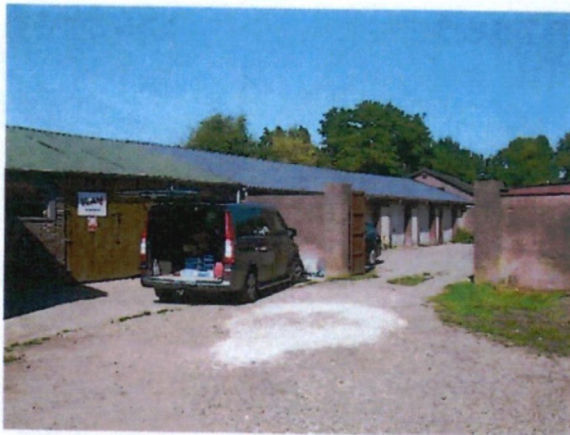
Gebouw D en A
