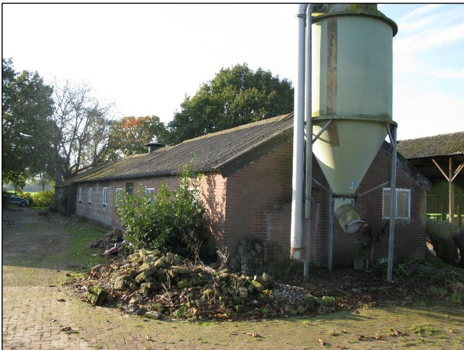
Figuur 7: Bijgebouw B2-B3 (wordt gesloopt)
