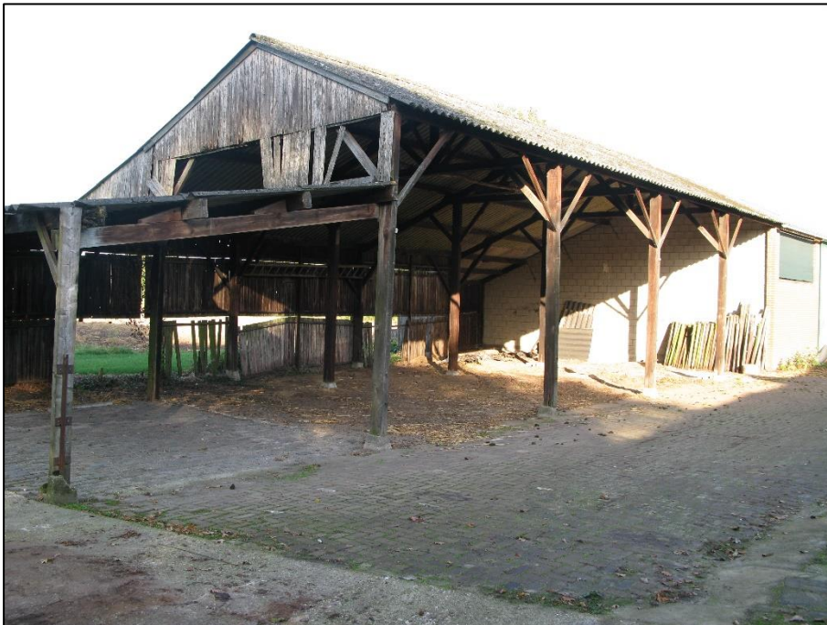
Figuur 9: Bijgebouw C2 (wordt gesloopt)
