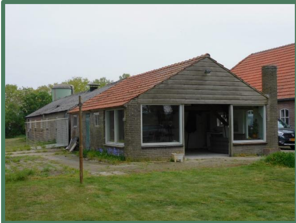
Overkapping van de berging met melkvee stallen
