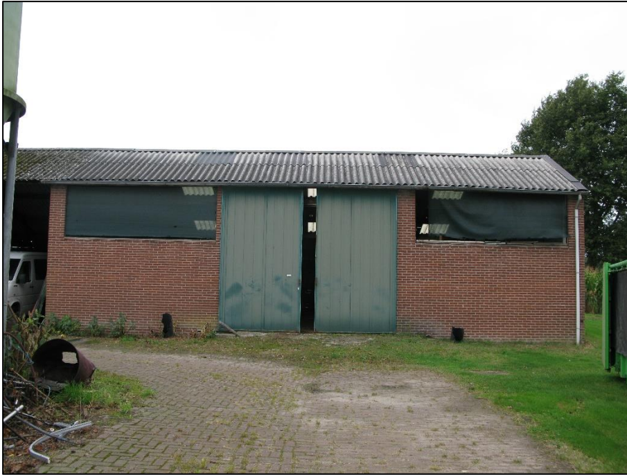
Figuur 8: Bijgebouw C1 (wordt gesloopt)
