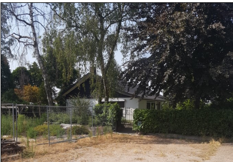
Figuur 8: Bedrijfswoning aan Achterweg 3
