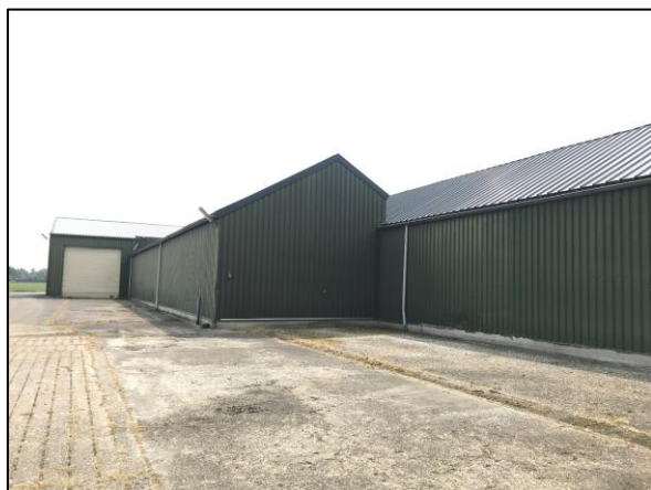
Foto 3. Loods oostzijde met verharding rondom
