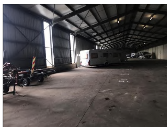
Foto 8. Stalling caravans in deel van de loods
