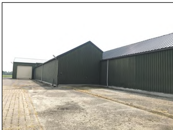
Foto 3. Loods oostzijde met verharding rondom
