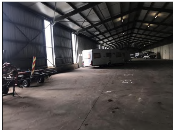
Foto 8. Stalling caravans in deel van de loods
