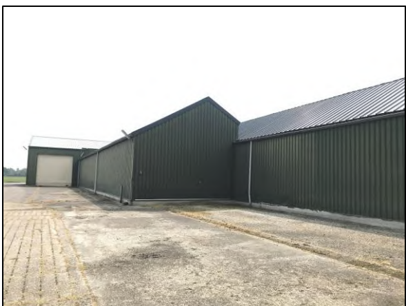
Foto 3. Loods oostzijde met verharding rondom
