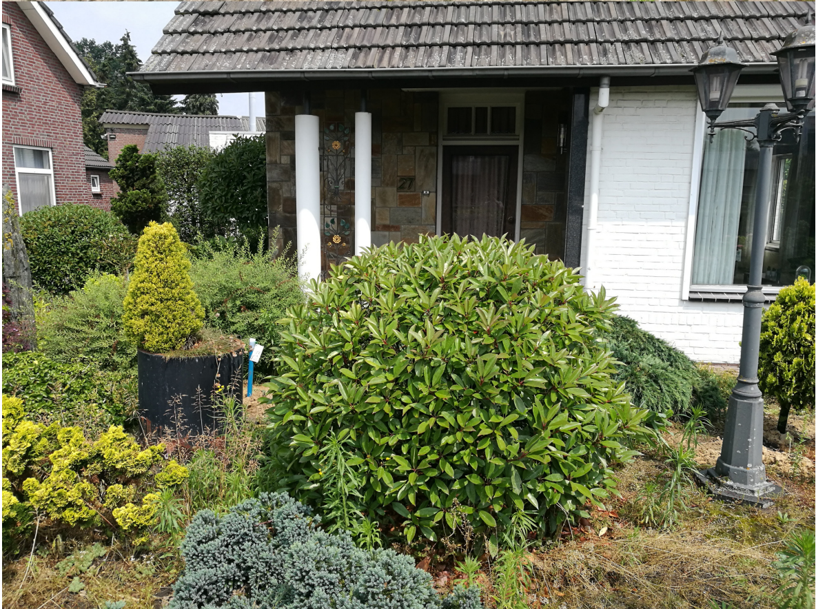
Foto's onderzoekslocatie – 8 juni 2018
