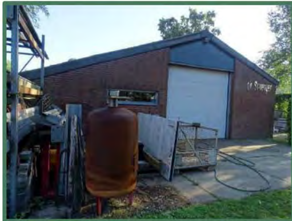
Te behouden zuidzijde loods op 503
