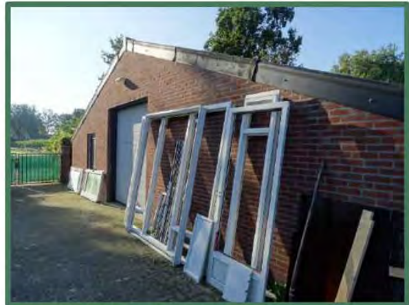
Te slopen noordzijde loods op 503
