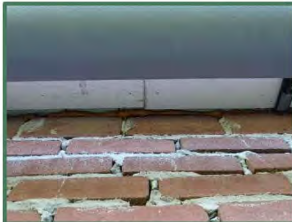
Met bouwschuim gesloten rand tussen het dak en de muur
