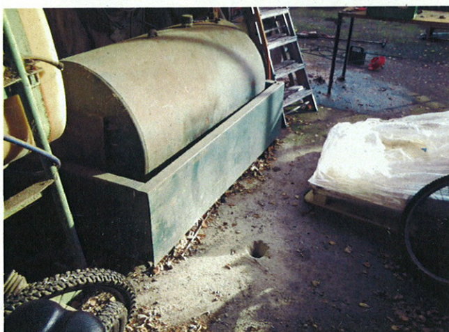
foto deellocatie bestaande bovengrondse tank
