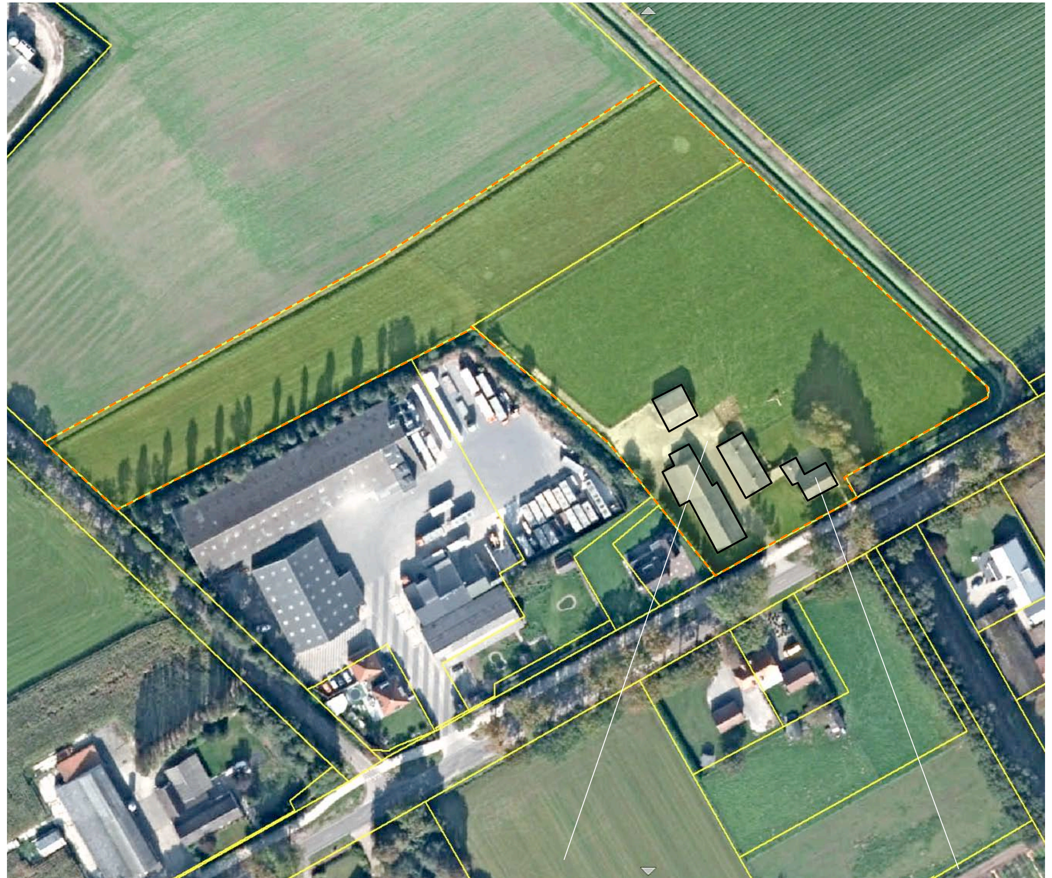
drie bedrijfsgebouwen en verhardingen
