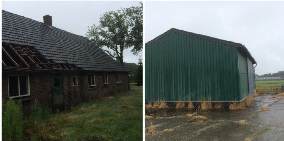
• Afbeelding 2 Foto's plangebied – (te slopen) bedrijfsgebouwen
