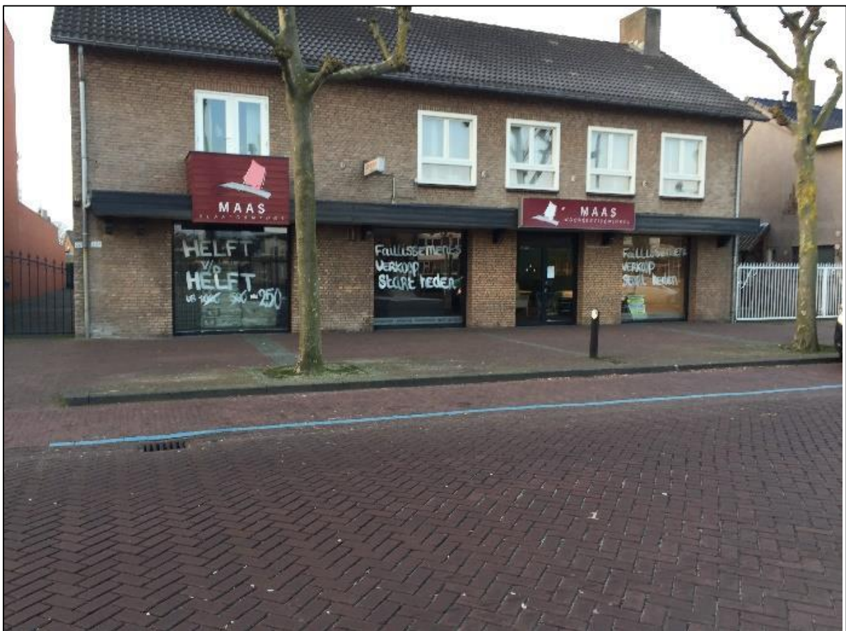
Zicht op de voorzijde van de projectlocatie vanaf het Wilhelminaplein (bron: Milon bv)
