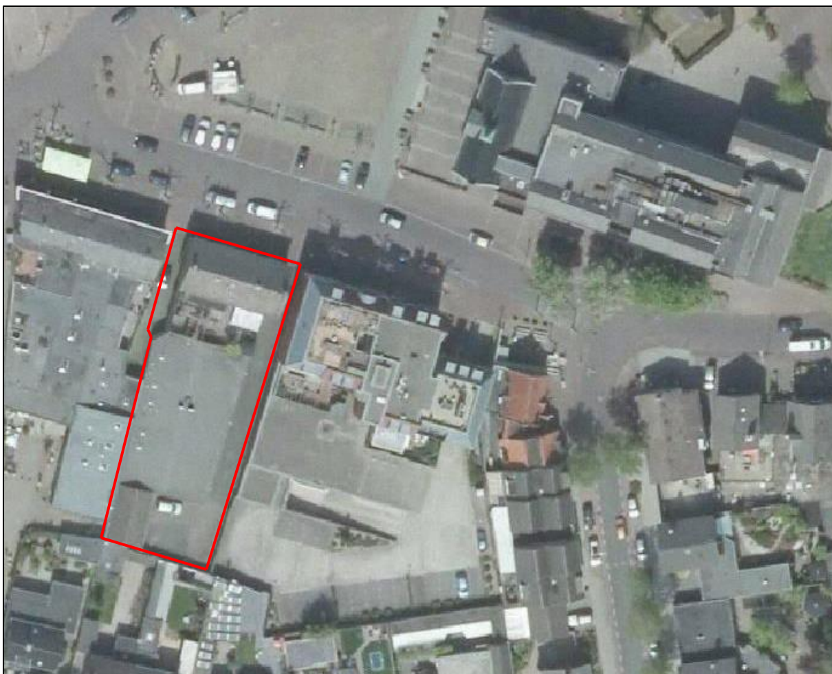
Luchtfoto en begrenzing van het besluitgebied Wilhelminaplein 26-26a
