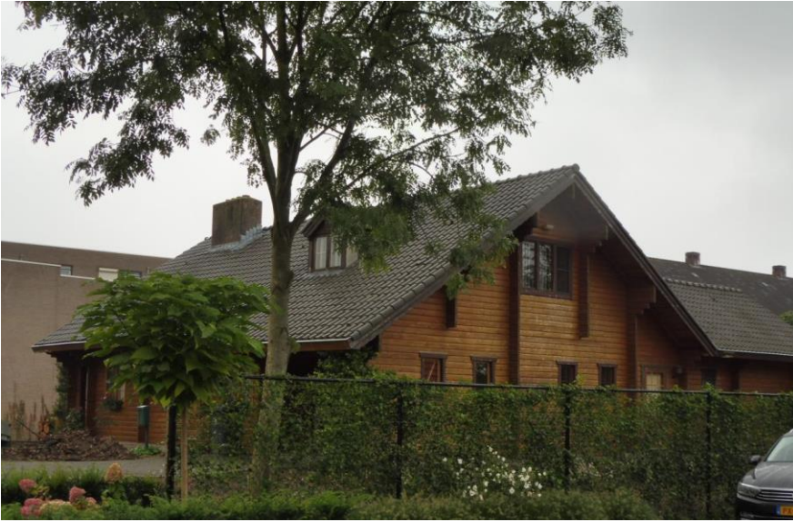
Aanblik bestaande woning Melcherstraat 7 met linksachter op de foto zicht op het appartementencomplex aan de Postelstraat
