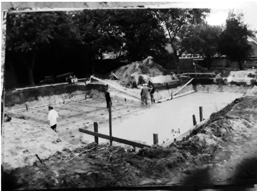
Figuur 12: Foto genomen na de ontgraving binnen de contouren van de huidige bebouwing (genomen in zuidelijke richting) 12
