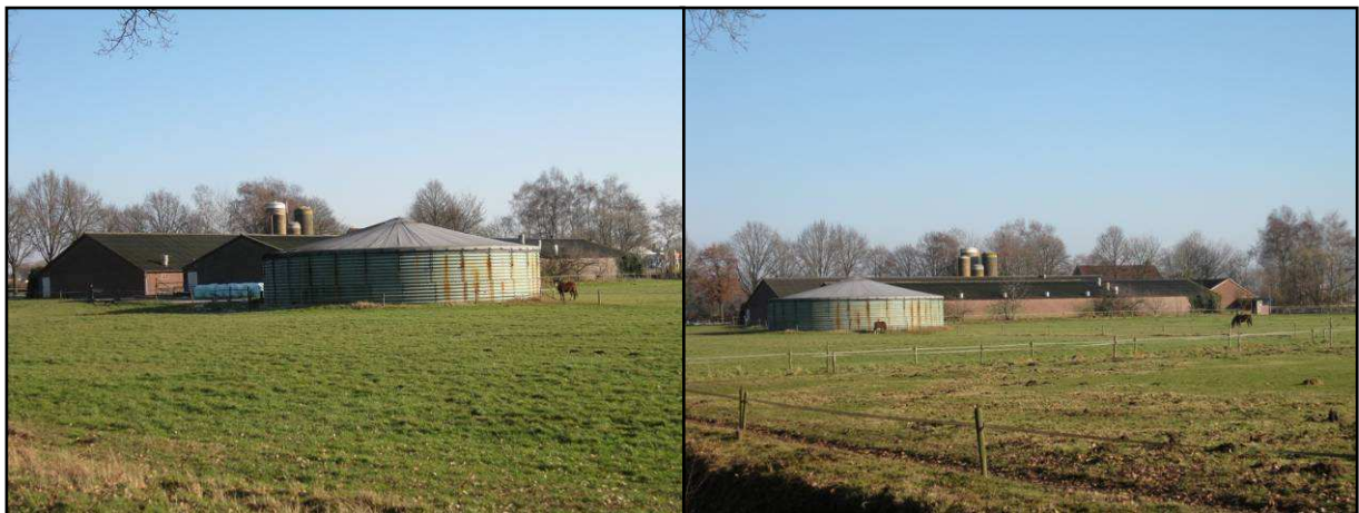
Figuur 6: Projectlocatie Kouterstraat 1
