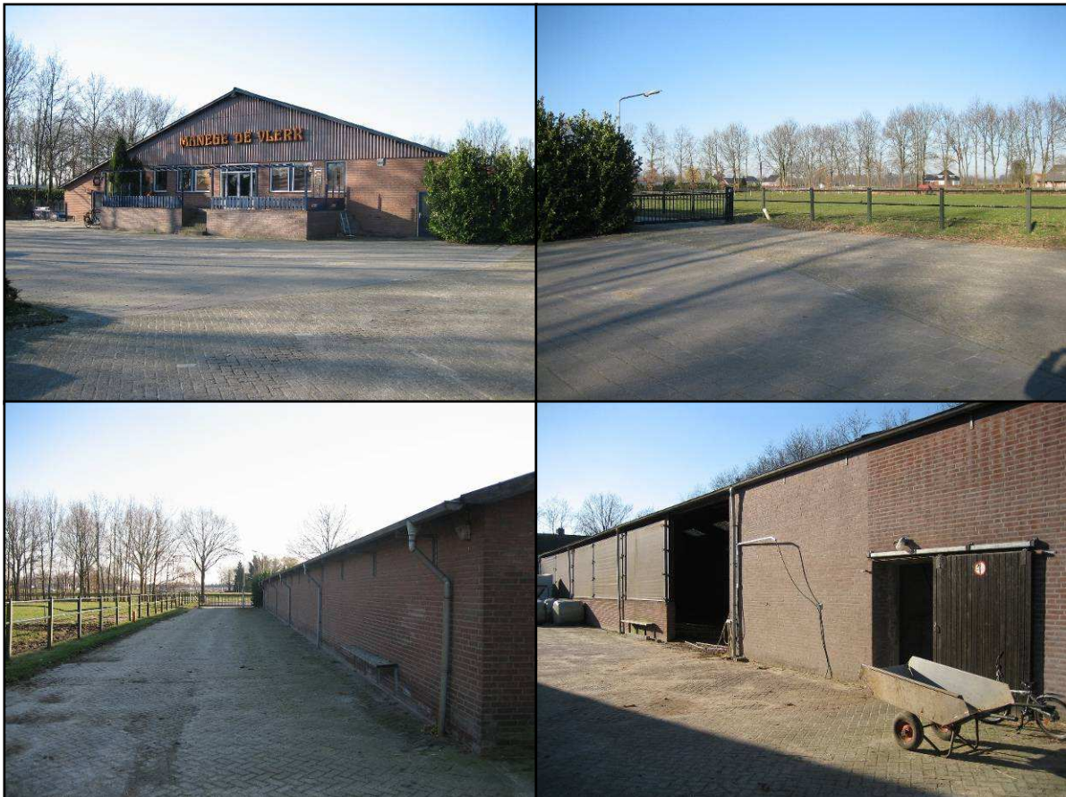
Figuur 8: Projectlocatie Kouterstraat 20
