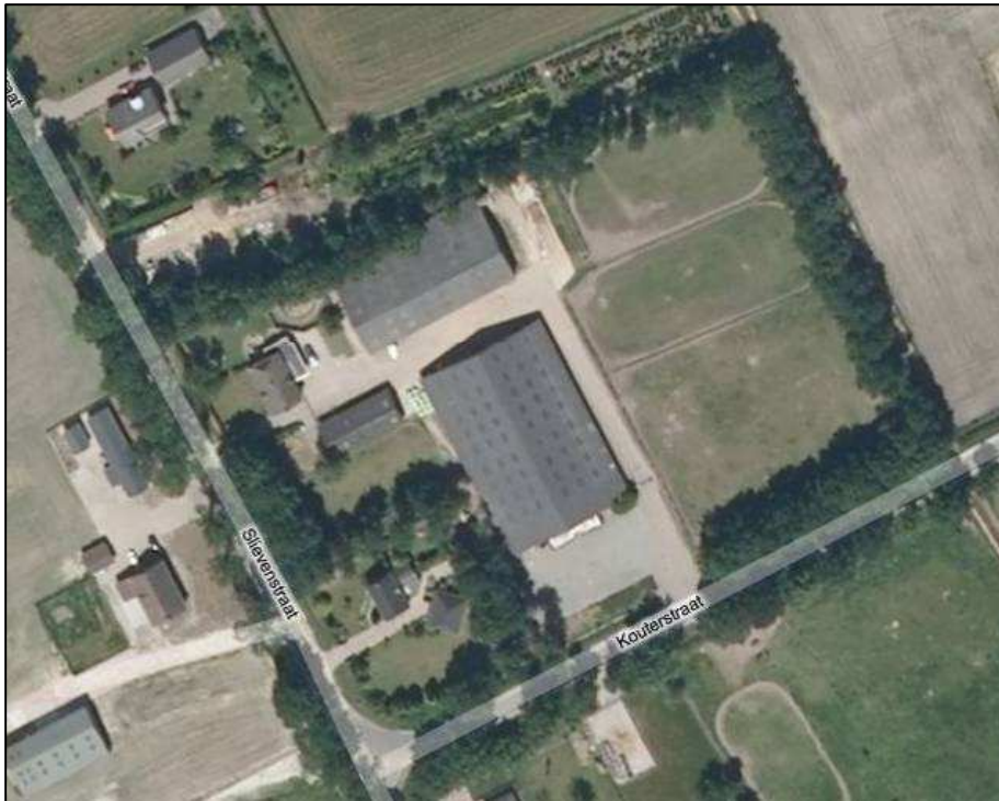
Figuur 7: Luchtfoto van de projectlocatie Kouterstraat 20
