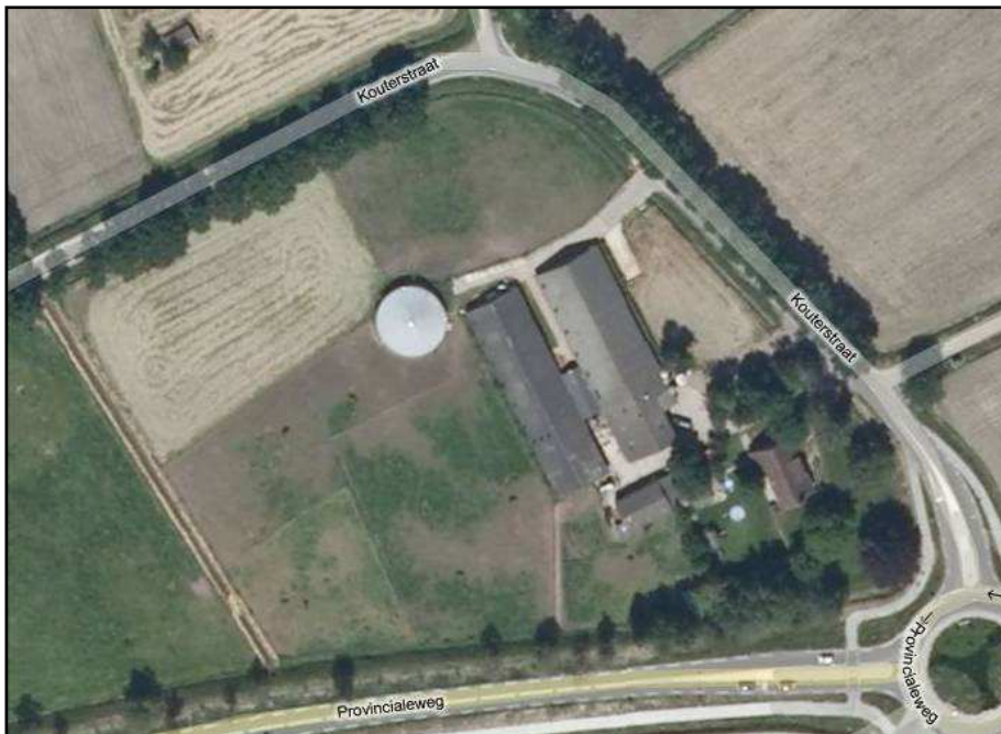
Figuur 5: Luchtfoto van de projectlocatie Kouterstraat 1
