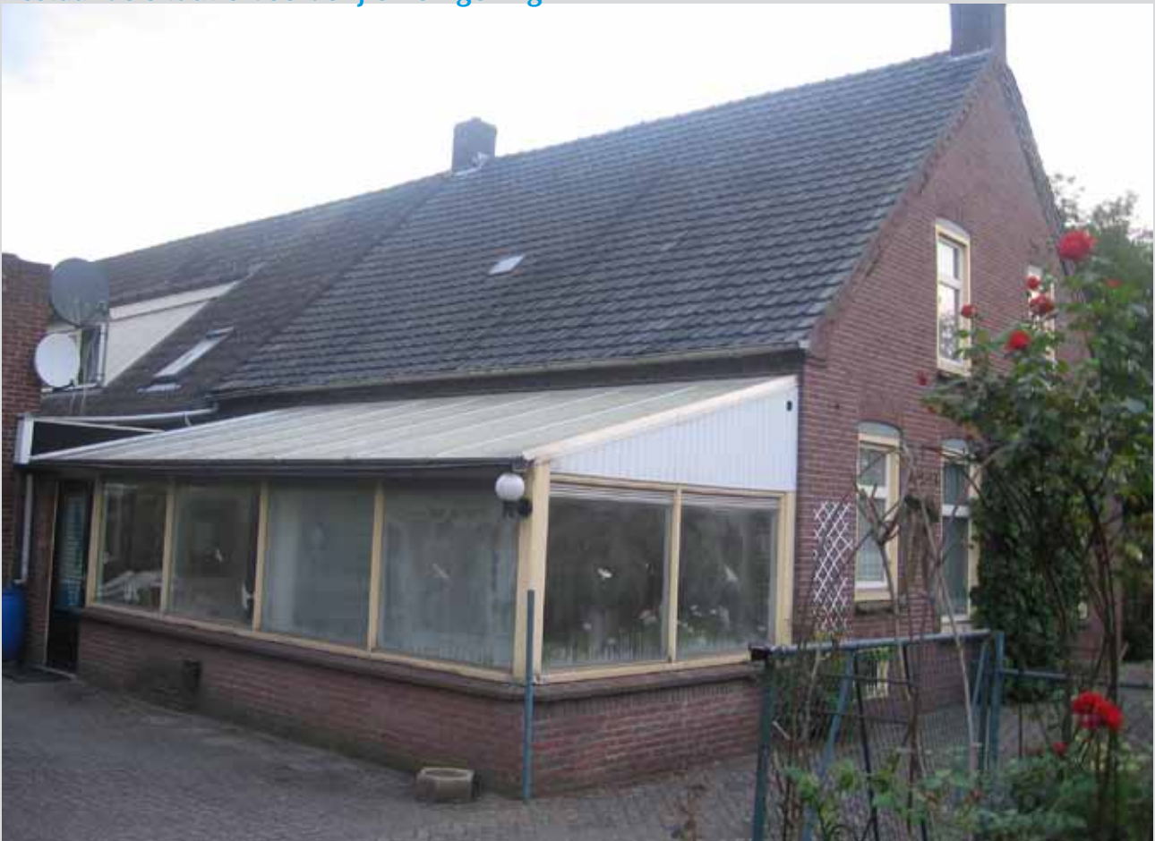
Achtergevel, serre Eindje 4
